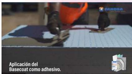
2.- Posterior a ello y antes de que seque, se coloca la malla fibra de vidrio; es necesario extenderla con una llana metálica del centro hacia los lados con el fin de eliminar cualquier tipo de imperfección que la malla nos pueda generar, permitiendo así un traslape de malla con la siguiente sección, dejando un traslape de al menos 5 cm.
