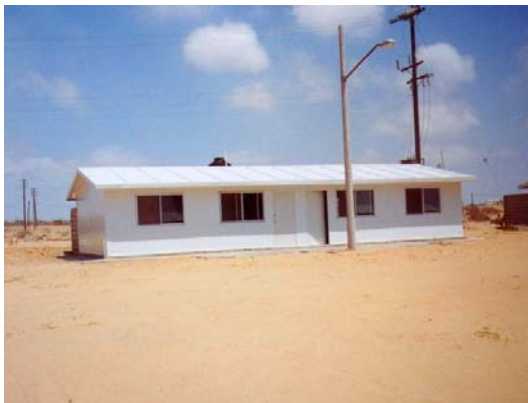
Casetas de CFE Baja California Sur 250 m 2 de muro, 150 m 2 de techo 400.00 m 2 C.U.
